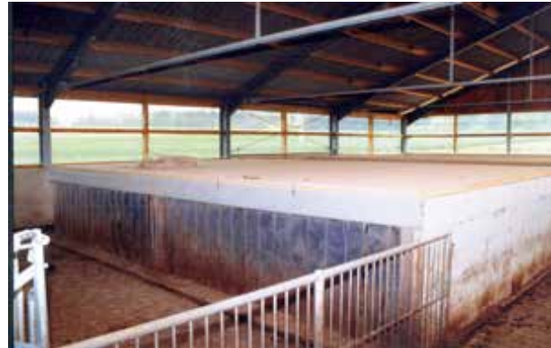
Abb. 5: Auch bei tragenden Sauen sind Einsparungen bei den Gebäudeinvestitionen z. B. durch einen ungedämmten Stall mit wärmeisolierten Ruheboxen möglich (Foto: Fritzsche)
