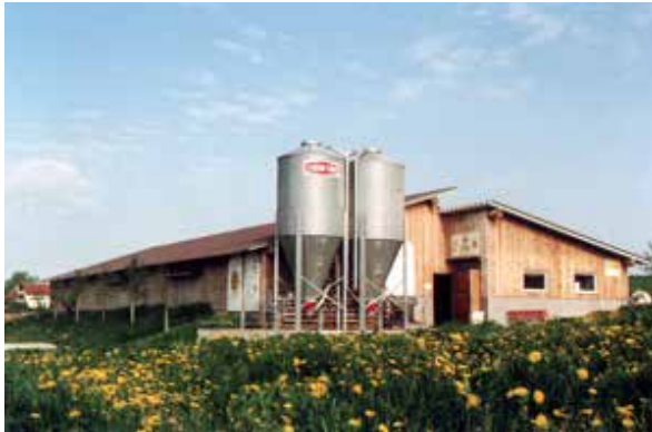
Abb. 4: Einfache Bauweise bei der Bauhülle spart Investitionen: Dach aus Trapezblech auf Rundholzkonstruktion und Schlitzwandschalung (Foto: Achilles)
