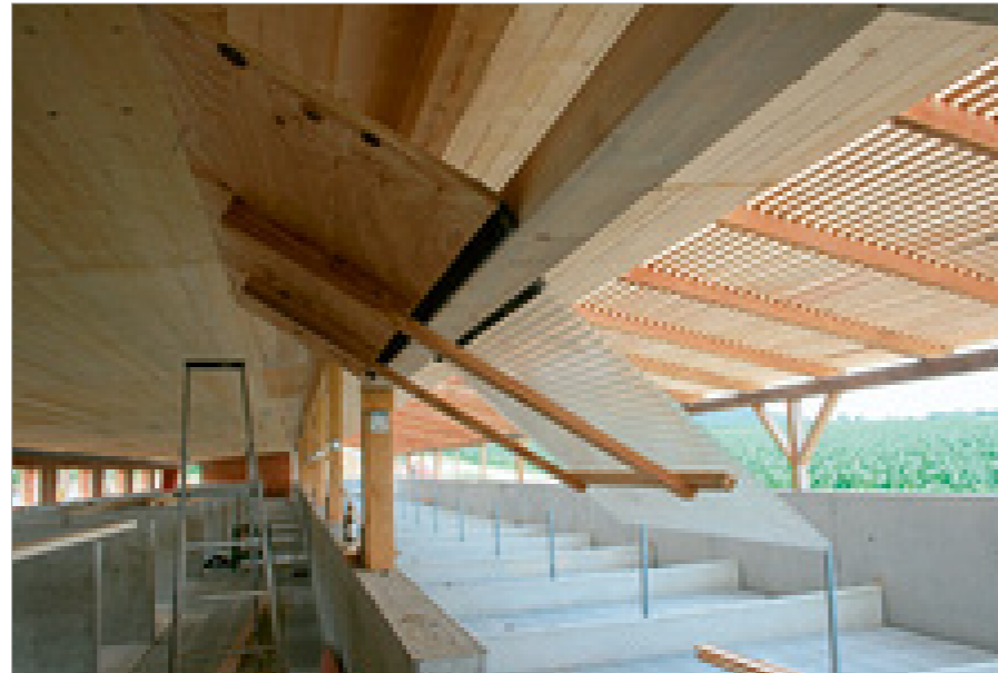
Abb. 19: Halb gekippte Wendeklappe aus Sperrholz im oberen Teil und Lichtstegplatte im unteren Teil
