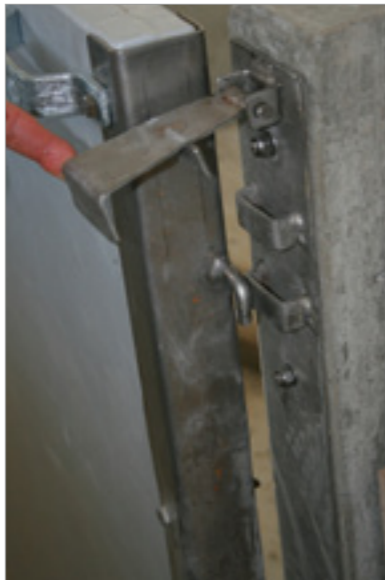
Abb. 12 - Der Türhaken kann in 2 verschiedenen hohen Positionen schweinesicher eingehängt werden
