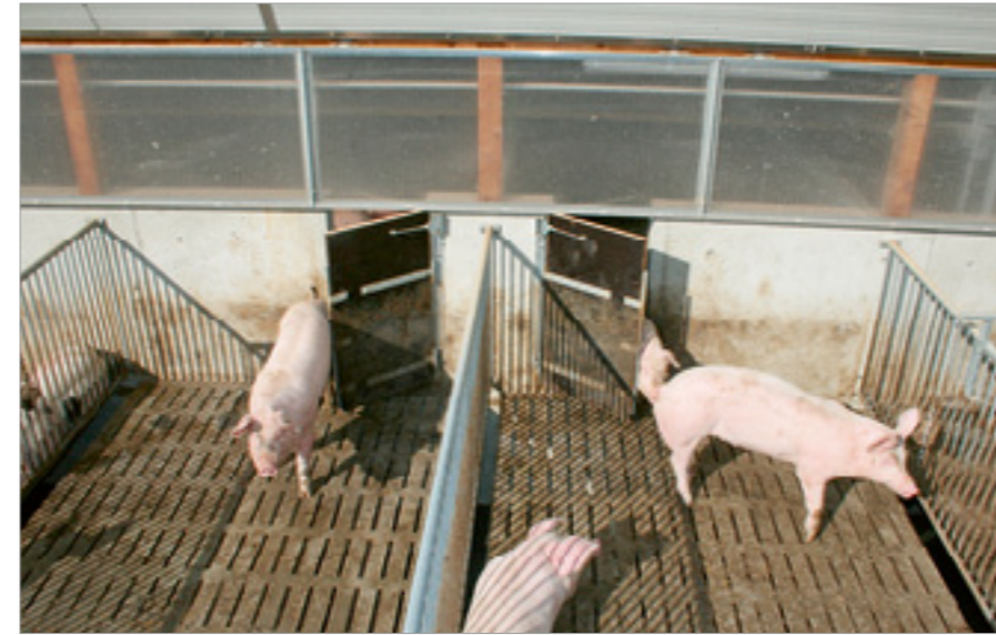
Abb. 21 - Auslauftüren dürfen nur bis ca. 90° öffnen, da sich sonst die Druckfedern überdehnen können
