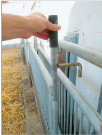
Abb. 18: Nach dem Schließen stehen alle überlappenden Tore auf dem Betonsockel (Bild Hagmüller, Wels)
